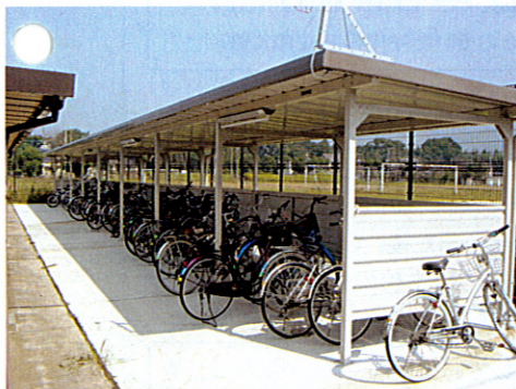
増設された駐輪場
