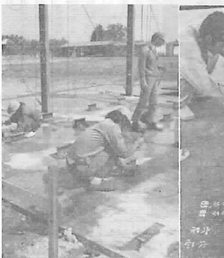
写真B 工作場定盤を設置するための鋼製枕取付け作業
