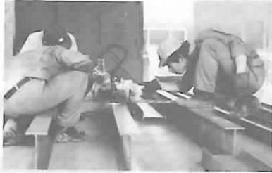
写真1 空気取入れチャンバー建築工事用の鉄骨の切断
