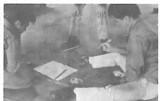
写真2 空気吹出しチャンバー ガラリ枠の現寸図作成
