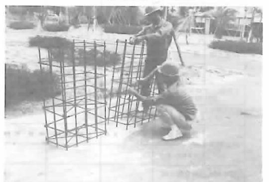
写真5. 風洞基礎鉄筋組立
