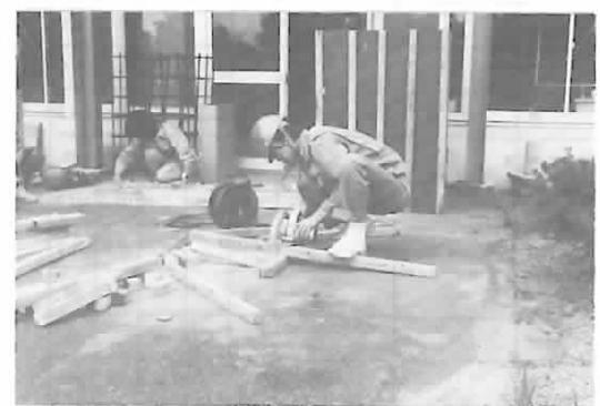
写真6. 風洞基礎型枠製作
