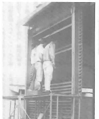
写真2 空気取り入れチャンバー北壁のガラリ取付
