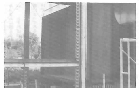
写真3 空気取り入れチャンバー内の風胴吸込み縮流部
