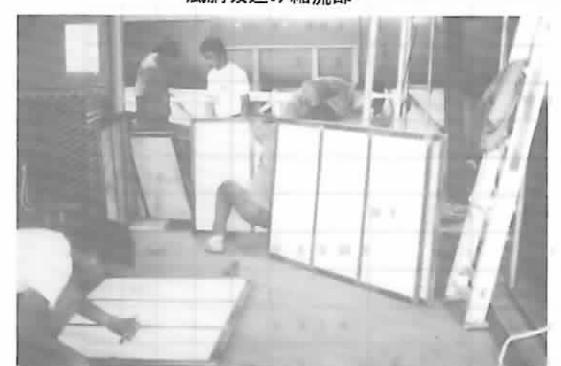
写真5 空気取り入れチャンバー フィルターの製作
