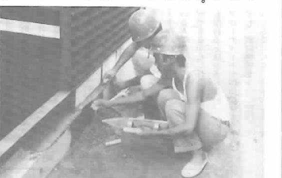
写真4 空気取り入れチャンバー外壁すきまをブロックにてふせぐ
