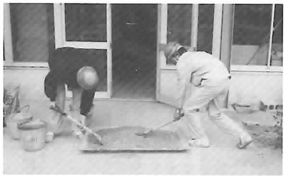
写真4 計測室拡張工事用コンクリートの練り混ぜ
