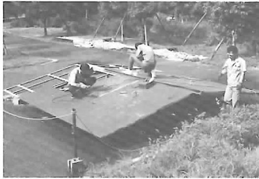
写真2 吹出しチャンバー屋根製作
