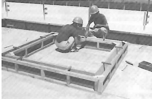
写真4 パッシブソーラーハウス基礎型枠組立
