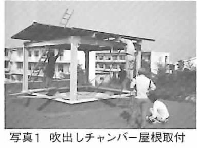
写真1 吹出しチャンバー屋根取付
