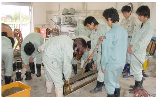
▲コンクリート打設
