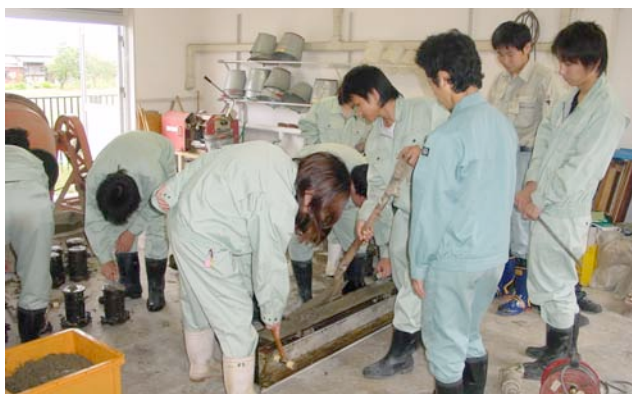
▲コンクリート打設 Concrete Casting
