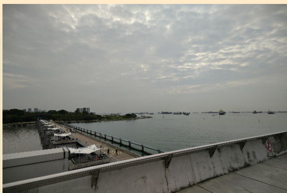
マリーナ・バラージ（中央の堰）。介して左側がマリーナ湾（淡水）で、右側がシンガポール海峡（海水）。海峡は交通の要衝で船舶が多く見える。
