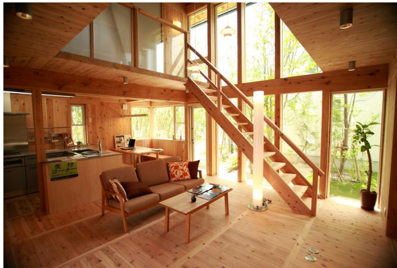
図 響きの家：2階床にパネル材を敷き込む。
