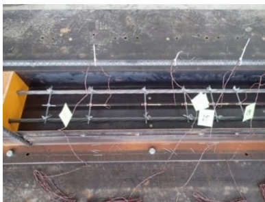
写真 1 試験体製作状況
