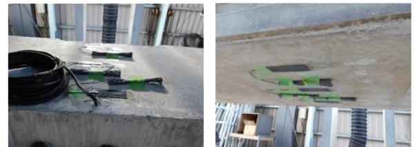
写真 4 曲げ試験体上下面のひずみゲージ貼付状況
