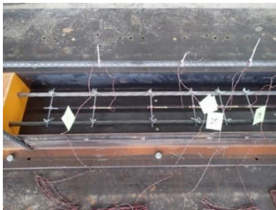
写真 1 試験体製作状況
