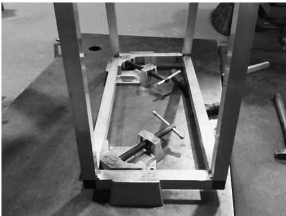
図3 アルミ角材の溶接作業
