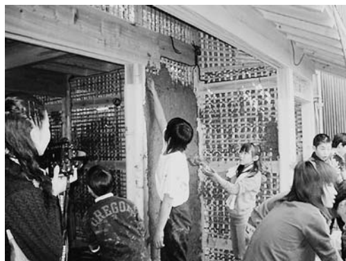
写真2 土壁を塗る小学生
