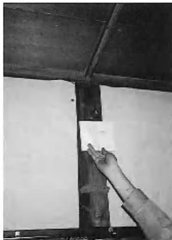
写真-6 水平加力時の小壁漆喰の浮き
