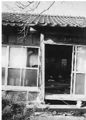
写真-5 水平加力時の柱の変形状況
