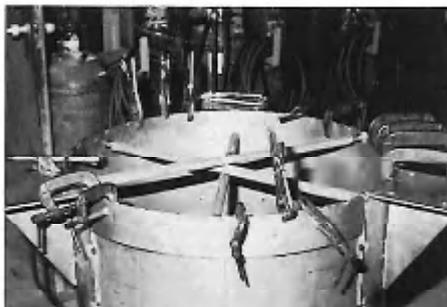
写真2 溶接前のクランプされた反応補強板
