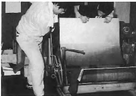
写真1 ローラ曲げ機によるU曲げ加工
