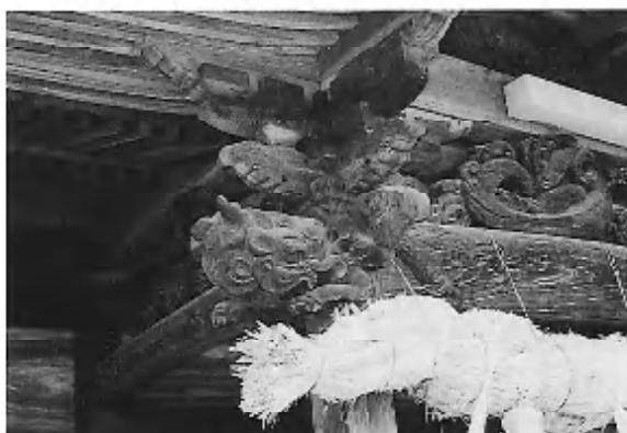
写真-26 拝殿向拝柱上部詳細
