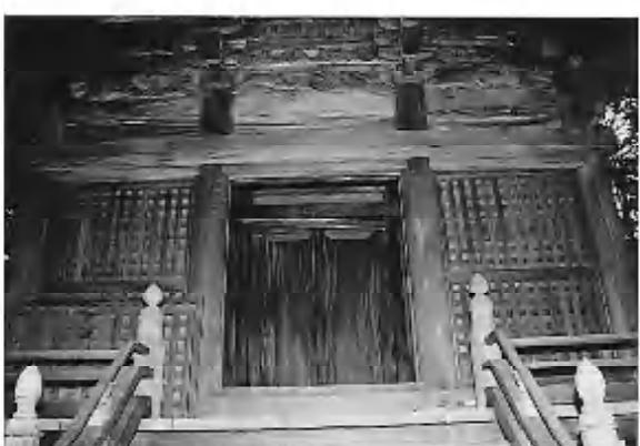
写真-21 本殿正面 中央間の部を取り外した状況
