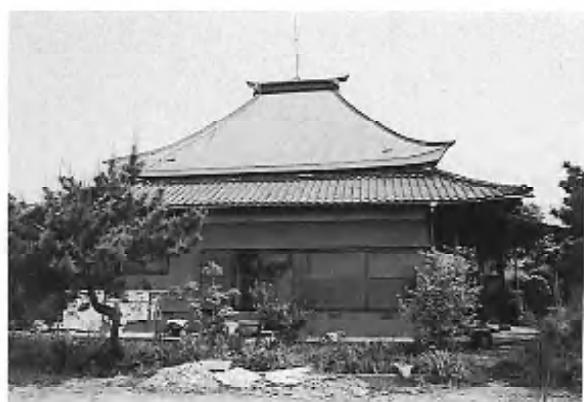
写真-30 淨光寺本堂 左側面(上屋茅葺型鉄板葺・下屋桟瓦葺)
