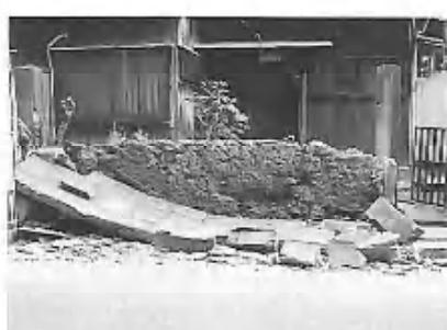
写真12 崩落したブロック塀
