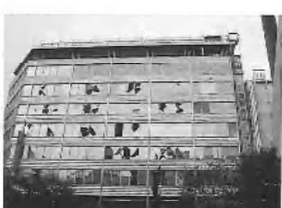
写真15 福ビルの窓ガラスの破損状況
