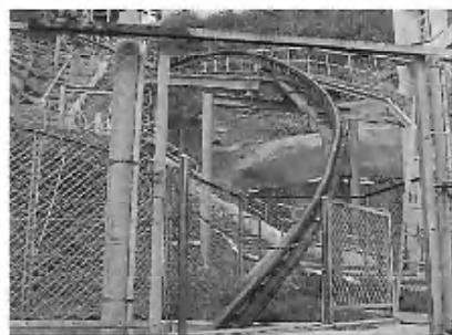
写真36 変形した軽量鉄骨製の構造物
