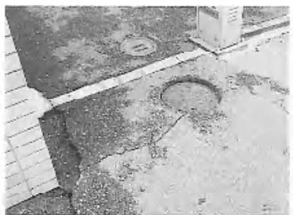
写真22 陥没したマンホール
