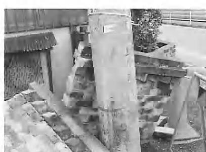
写真13 崩壊したブロック塀
