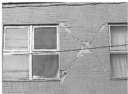
写真1 短柱のせん断破壊
