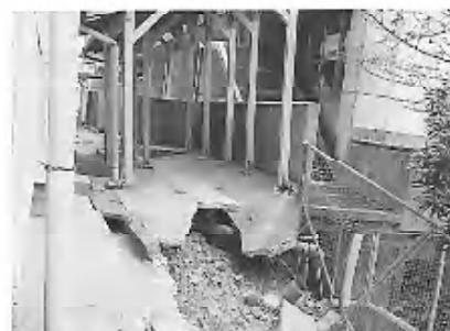
写真30 崩壊した地盤
