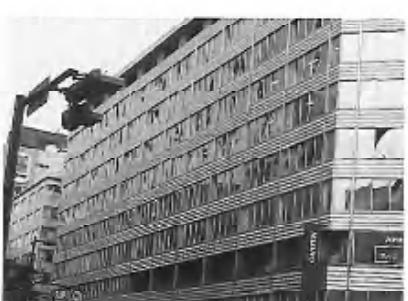
写真14 福ビルの窓ガラスの破損状況
