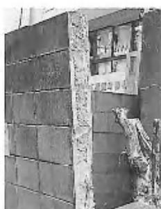
写真10 傾斜したブロック塀
