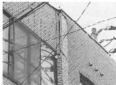
写真6 損傷した外装材(仕上げ材)
