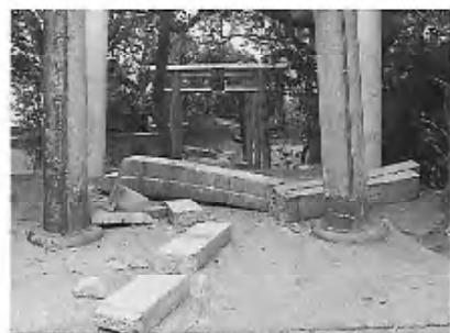
写真37 一部が崩壊した鳥居
