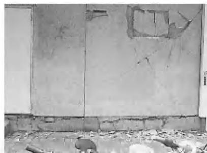
写真5 損傷した外壁
