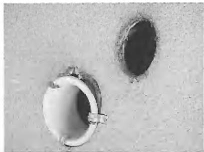
写真26 損傷した換気口の取りつけ部
