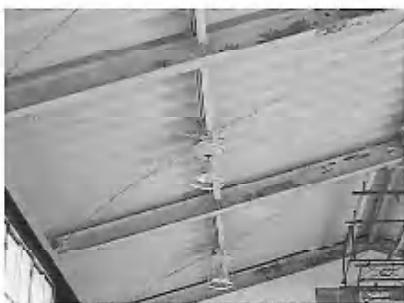
写真35 座屈した屋根面のプレース
