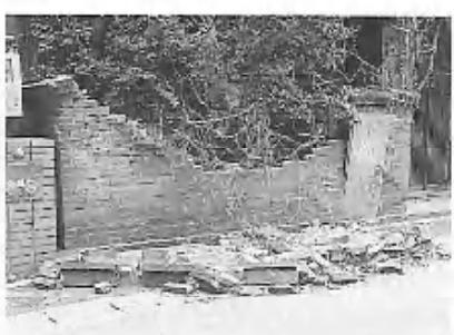
写真11 崩落したブロック塀
