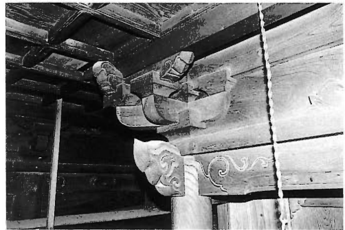
写真-28 内陣柱上部
