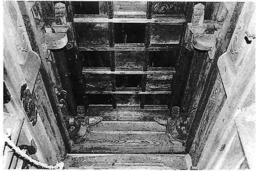
写真-22 正面1間吹き放し部分の天井
