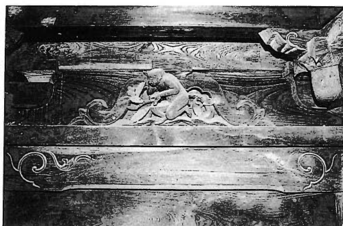
写真-36 内外陣境右脇間
