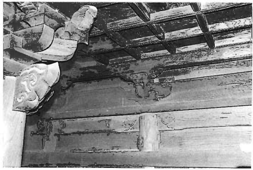
写真-23 内陣天井
