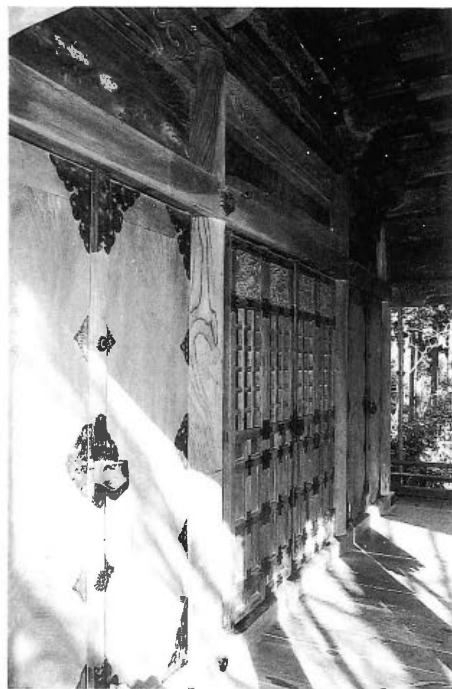
写真-39 売比多神社本殿正面1間吹放し部分
