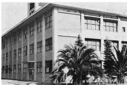
写真2 工業化学棟西西北側撮影 1階西側化学工学実験室 2階西側化学工学研究室 3階西側計測（分析機器）室
