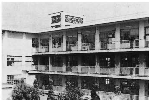
写真1 工業化学棟南東側撮影 1階東側分析化学研究室 1階中央分析化学・電気化学実験室 1階西側化学工学実験室 2階東側物理化学・有機化学実験室 2階中央有機化学・高分子化学研究室 2階西側化学工学研究室 3階東側4学年・5学年用教室 3階中央工業化学科事務室・教官室 3階西側計測（分析機器）室 その他建屋南側に薬品・資材庫2棟
