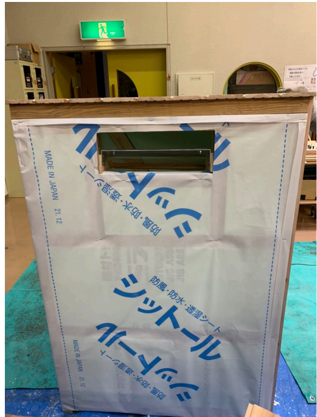
図10. 枠組みに断熱材をはめ込み防水シートを張り付けた様子
