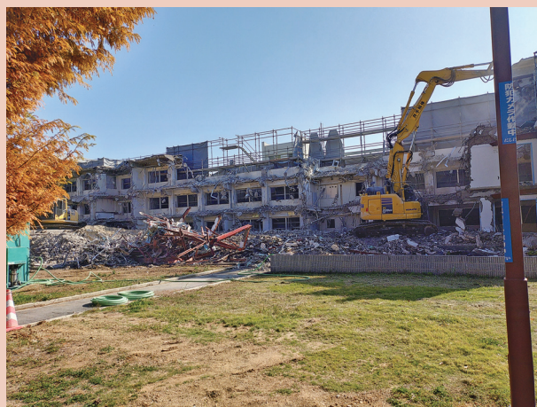
若葉棟解体工事中
